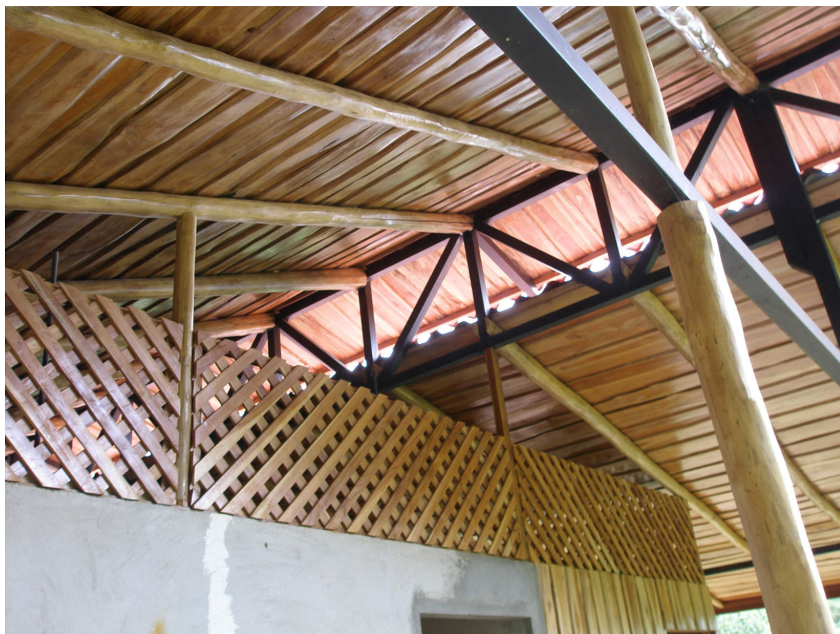
Particolari della struttura del tetto in acciaio e legno
